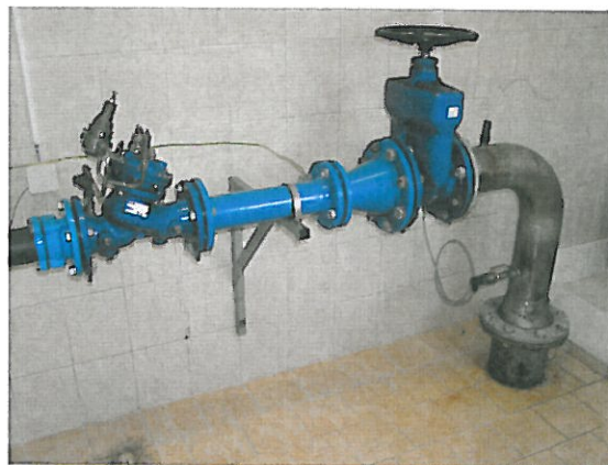
odtok s redukčním ventilem a chlorace
