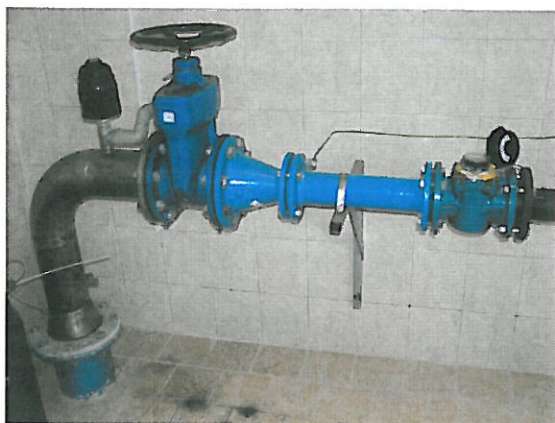
Objekt Dochlorace nátok s odvzdušňovacím ventilem a vodoměrem
